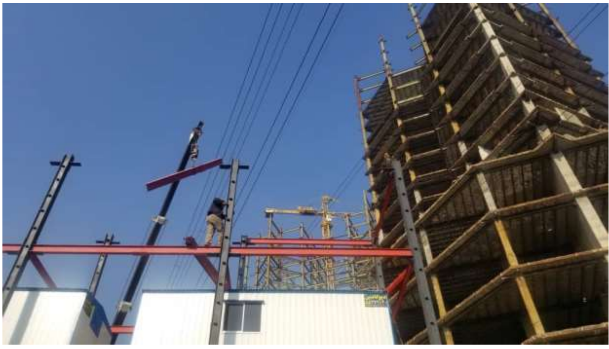
تجهیز کارگاه (مرداد ۹۹ - دی ۹۹)
